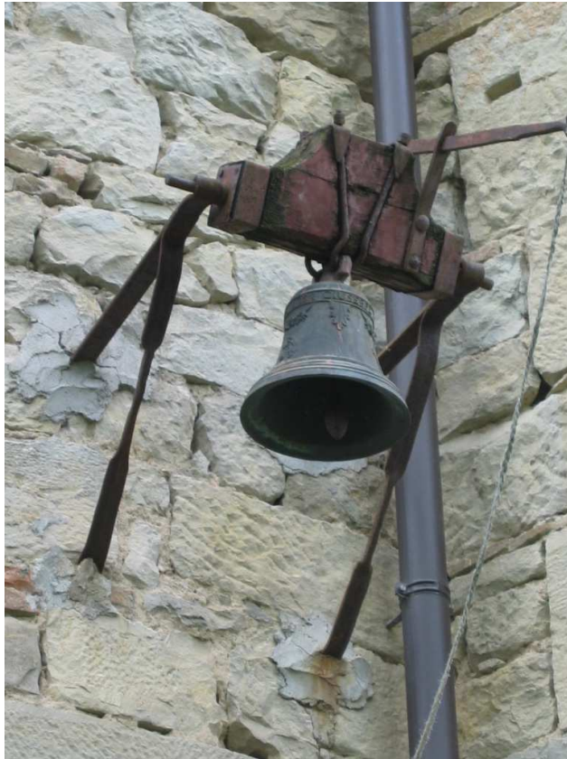
Foto n. 76: Oratorio di S. Andrea, particolare
