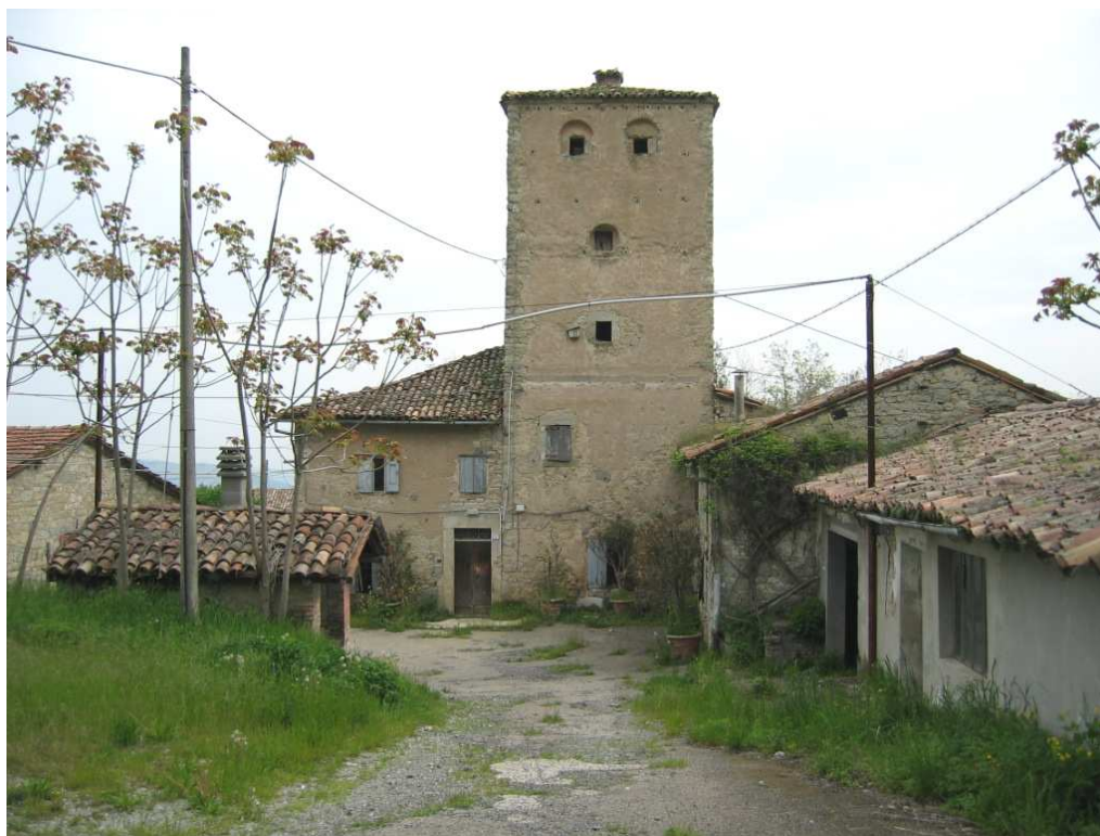
Foto n. 65: Cà Bergantino, fronte verso la corte
