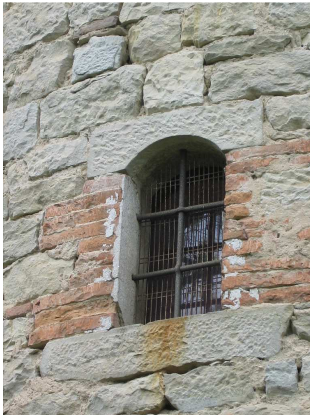
Foto n. 77: Oratorio di S. Andrea, particolare
