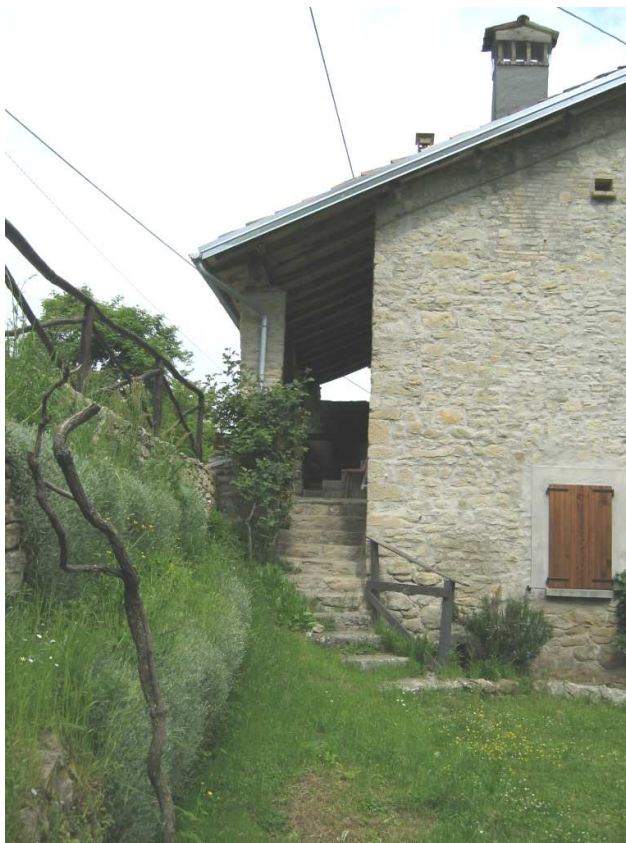
Foto n. 95: Cà Bortolomeo, veduta laterale del portico
